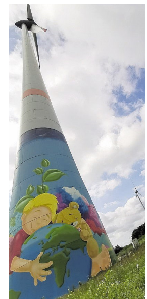
Knapp 230 Meter ragen die Windenergieanlagen in die Höhe. FOTO GEWERT
